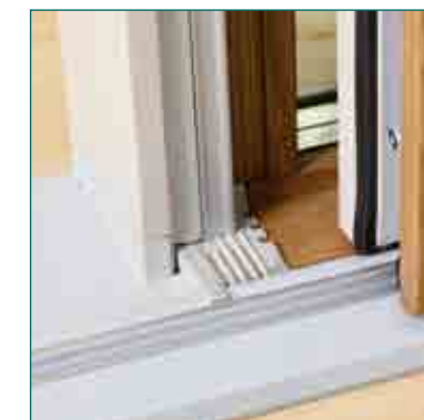
Gomma e guarnizione di tenuta all'acqua nel montante centrale
