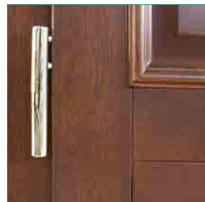
CERNIERA 3D: Indicata per portefinestre e portoncini. La sua regolazione è tridimensionale. diametro disponibile: ø 16 - ø 20
